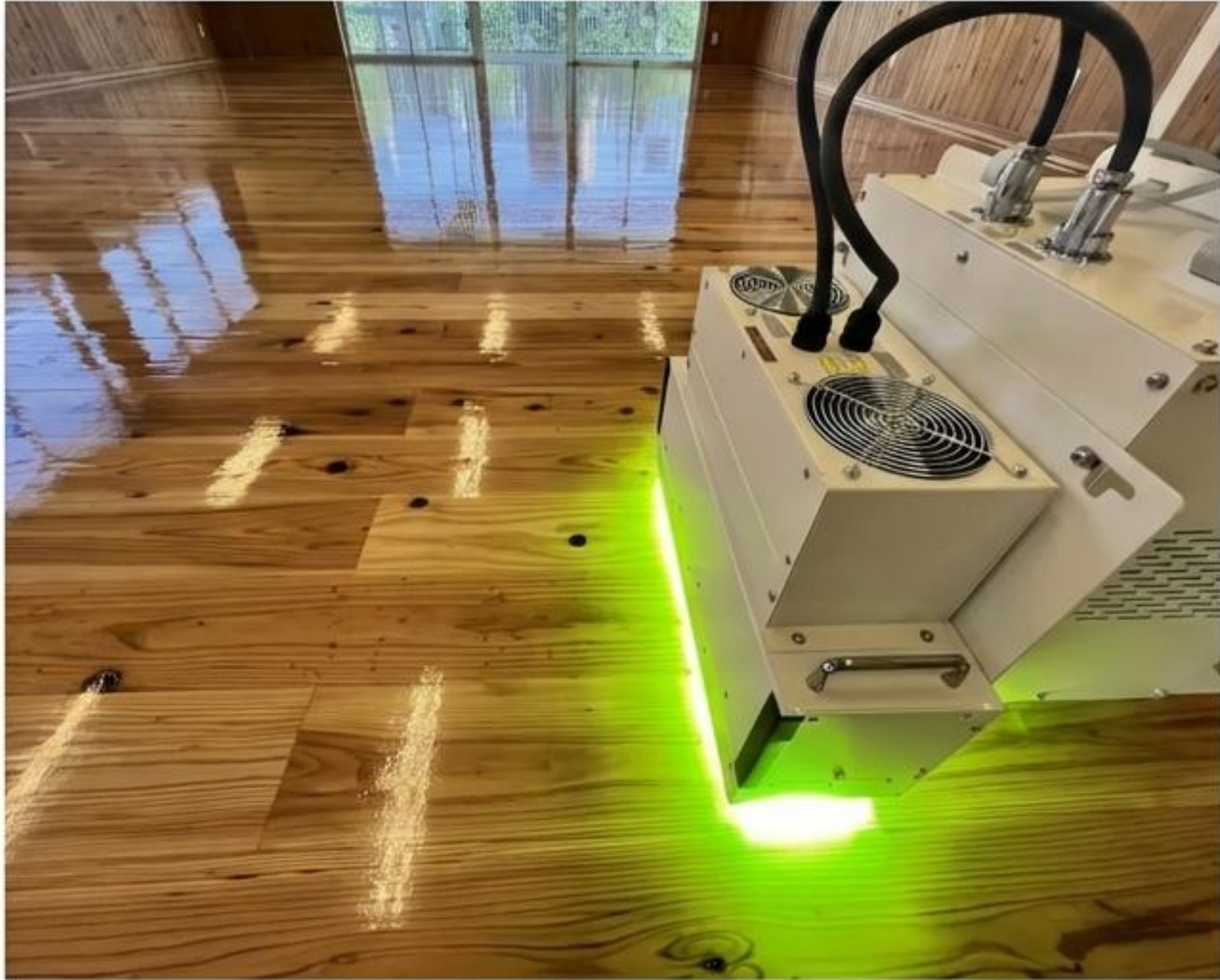
UV 바닥재 코팅: 실제 시공 현장에서 입증된 빠른 경화 속도와 뛰어난 내구성.
